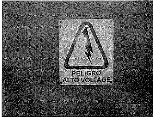
Figura 29. Rótulos de precaución eléctricos.
