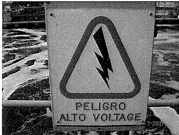
Figura 30. Rótulos de precaución eléctricos.
