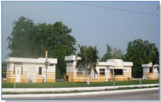
ESTACIÓN DE CONTROL, PUERTO QUETZAL, ESCUINTLA KM. 98+639 RUTA CA-9 SUR "A"
