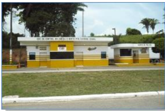
ESTACIÓN DE CONTROL, PUERTO BARRIOS, IZABAL, KM. 288 RUTA CA-9 NORTE
