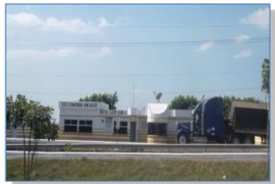
ESTACIÓN DE CONTROL, ESCUINTLA KM. 64+629 RUTA CA-9 SUR "A"
