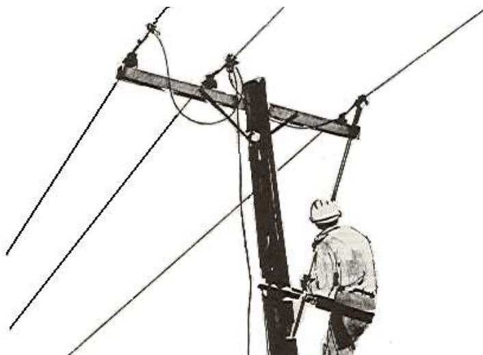
Figura 14. Puestas a tierra para protección del personal
