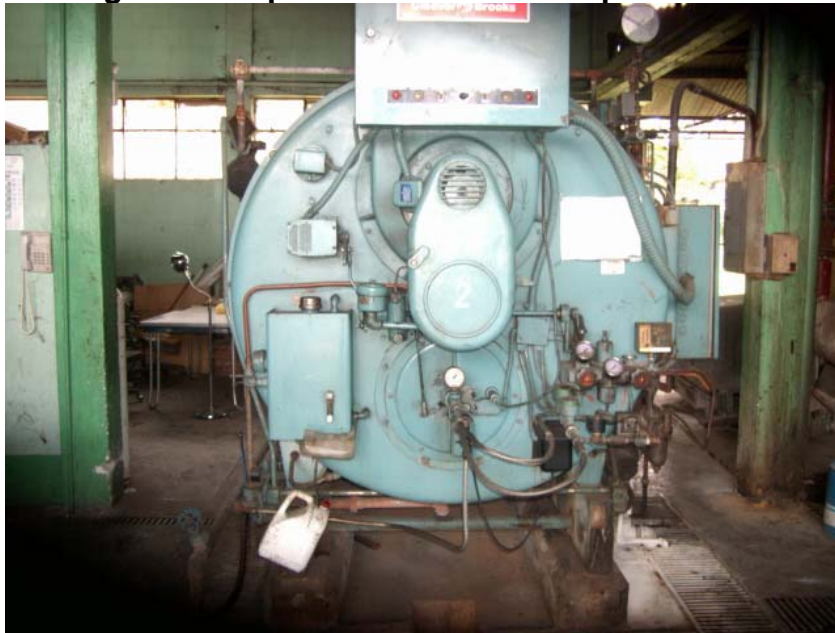
Figura 3 Esquema de una caldera pirotubular
