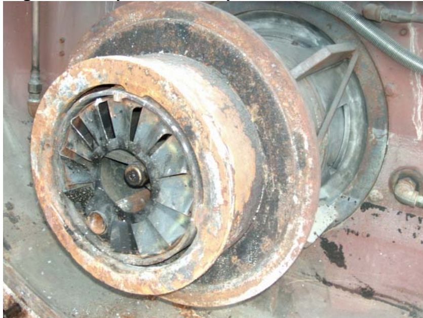
Figura 4 Componentes del quemador de combustible
