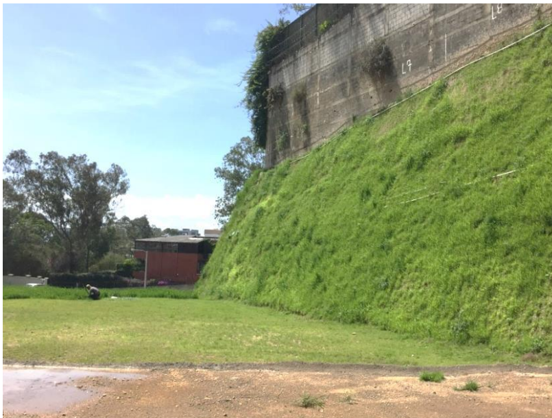
Figura 7. Talud de corte relación 3:1, 75 días luego de su aplicación.
