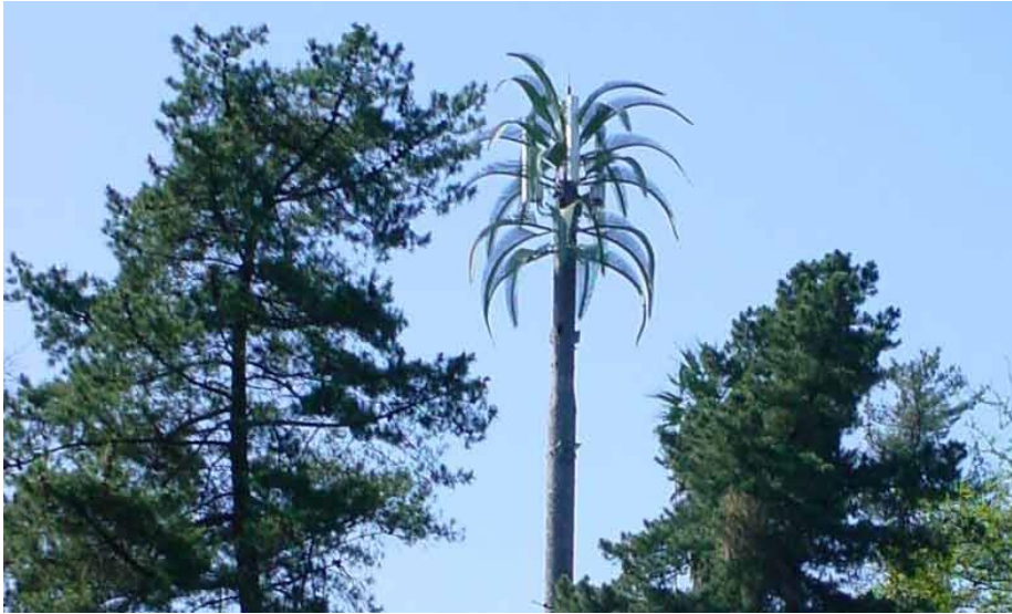
Figura 23. Poste tipo monoposte ecológico
