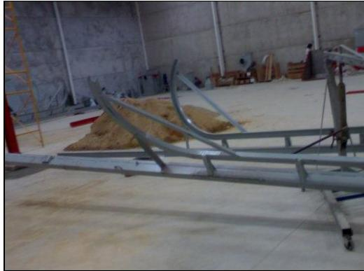
Se muestra la secuencia de montaje del equipo de elevación. Como se observa, los rieles se anclan a un metro bajo el nivel del suelo. Los rieles fueron elevados en la posición mostrada, más adelante fue necesario girarlos para colocarlos correctamente.
