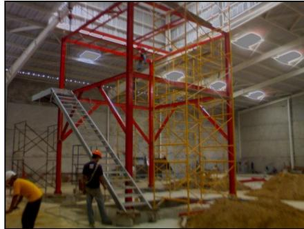
El equipo de elevadores es el conjunto de peso más elevado, y de manejo más difícil debido a su asimetría geométrica. Se ensambló el motor y el equipo de potencia en el suelo al conjunto de rieles del elevador. De la misma manera se ensambló el cangilón a nivel de suelo, y con esto se inició la elevación del conjunto completo. En la figura 34 se muestra el motor y el equipo de potencia, y en la figura 35 se muestran los rieles del elevador.
