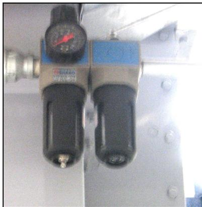
Al fluir aire comprimido a través de tuberías largas y a través de trayectorias curvas el agua contenida en el aire tiende a liberarse, por lo cual las tuberías se diseñan con una inclinación que permite que el agua fluya y no se acumule en las tuberías. Para extraerla se utilizan trampas de agua, que se drenan regularmente.
