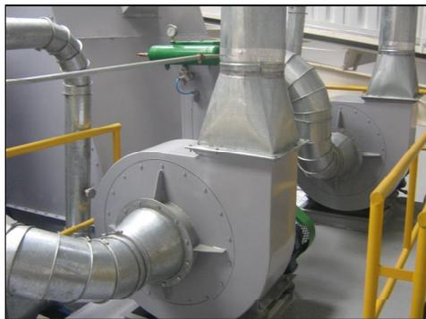
Los ventiladores se deben sujetar a la estructura por medio de anclajes anti vibratorios, por lo que la base se sujetará a la estructura por medio de soldadura, y los ventiladores se sujetaran a dicha base por medio de dichos anclajes. Dichos ventiladores deben colocarse en el tercer nivel de la torre, que se ubica a siete metros sobre el nivel del suelo, y poseen una masa de 500kg aproximadamente.
