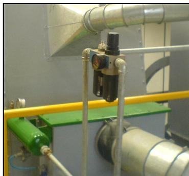
El ramal que conduce aire hacia los accionamientos neumáticos debe garantizar que la presión no supere la estándar para un sistema neumático, y su lubricación debe ajustarse a las condiciones de operación, que tienden a regular la dosificación a una tasa más elevada que la requerida para el sistema de filtros.
