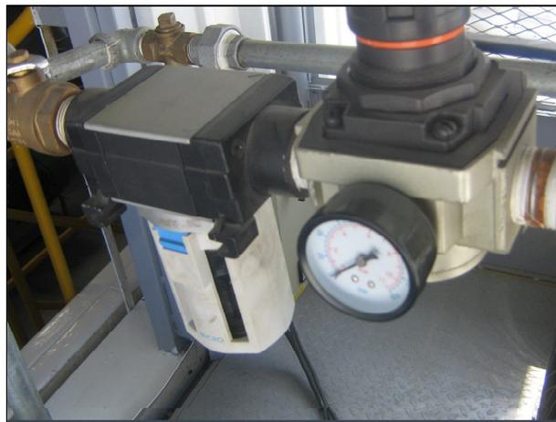
La línea principal fue diseñada con tubería de 1" de diámetro, lo que permite que el regulador y el filtro principales sean de constitución robusta. Además cabe destacar que el regulador contiene un dispositivo de desfogue que opera en el caso de fluctuaciones de presión que provoquen picos de presión que superen la capacidad máxima para la cual fue diseñado el regulador, usualmente 150psi.
