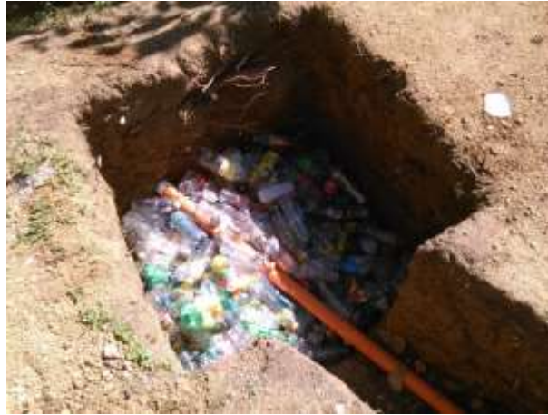
Figura 16. Colocación de material pet en el prototipo
