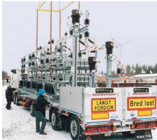
Figura 82 Módulo de banco de condensador preparado para el transporte
