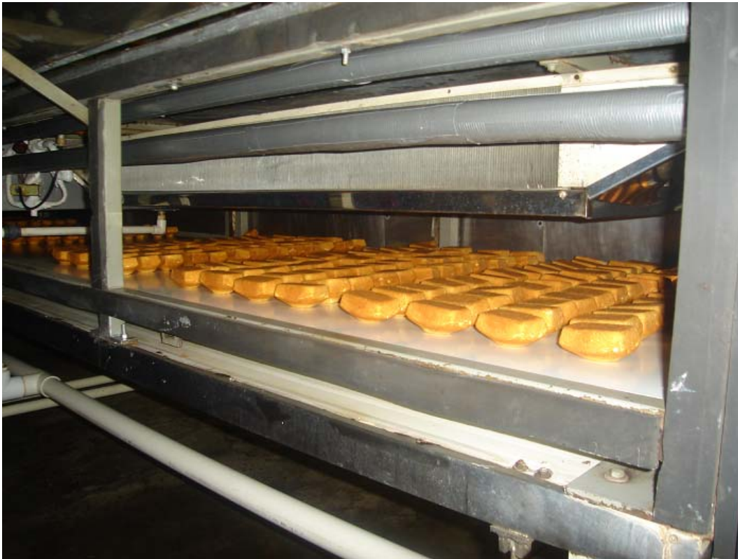
Figura 35. Túnel de banda sanitaria
