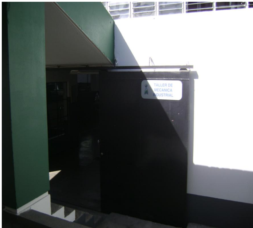
Figura 1. Taller de Mecánica Industrial.
