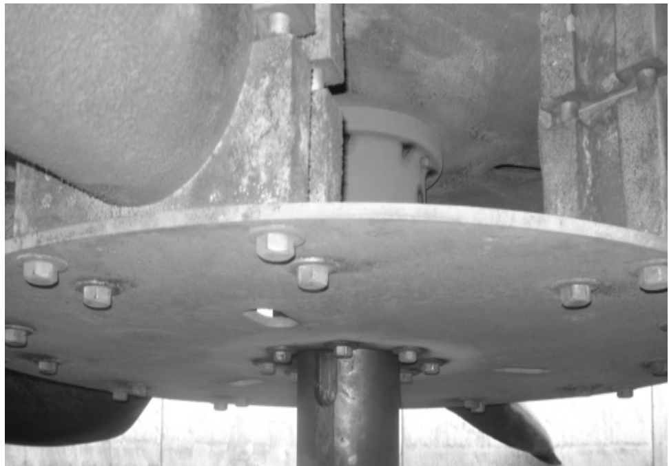
Figura 17. Coupling apriete de aspas del ventilador
