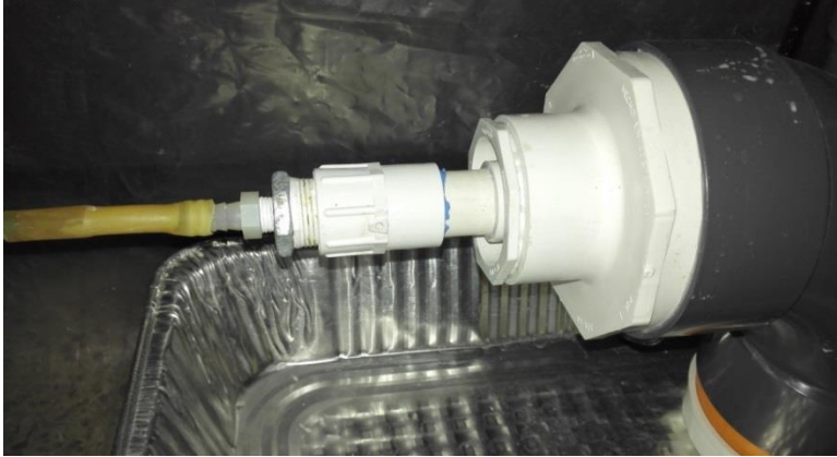
Figura 9. Acoples de entrada al reactor UASB
