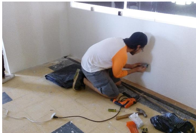
Figura 120. Voluntario realizando la instalación de tubería y cajas.
