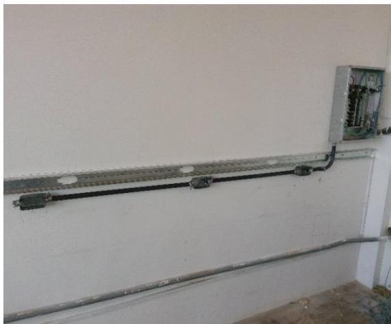
Figura 118. Instalación tubería y cajas
