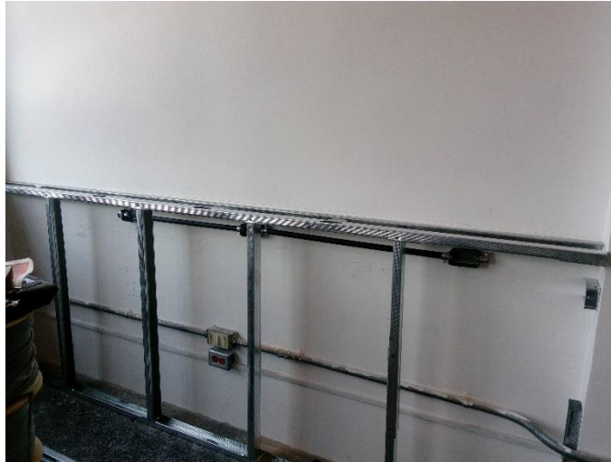
Figura 119. Instalación tubería y cajas previo a la instalación del cable
