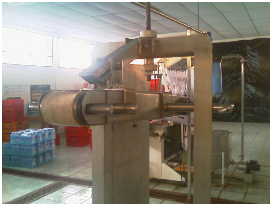
Figura 10. Parte del sistema de taponado que no está en funcionamiento.
