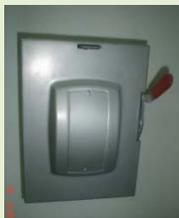
Conectar la máquina al flip-on general que se encuentra a un costado, en la parte posterior de la máquina.
