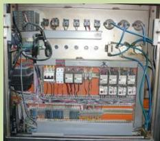
Limpiar el panel de control y revisar el circuito eléctrico. NOTA: No limpiar con presión de aire, puede ocasionar daños al circuito eléctrico).
