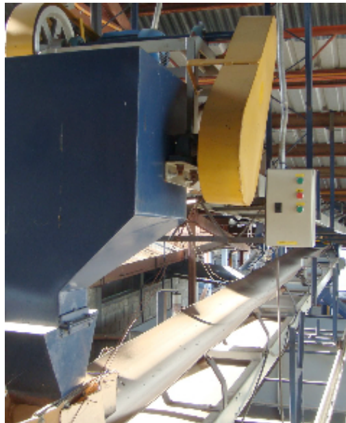
Figura 46 Instalación de panel de control de banda distribuidora
