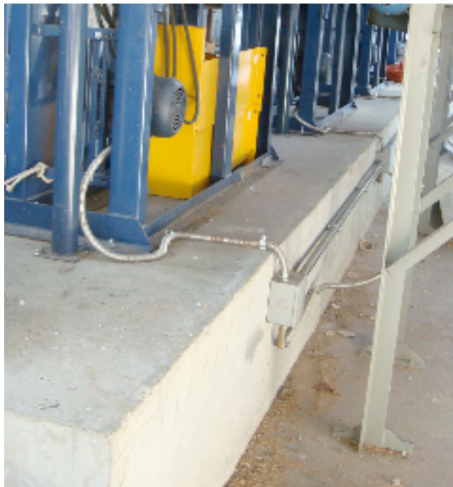
Figura 41 Cimiento para soporte de estructura
