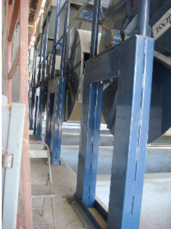
Figura 44 Estructura metálica para la instalación de chumaceras de secadoras
