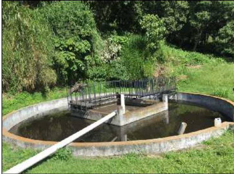
Figura 10. Sedimentador secundario
