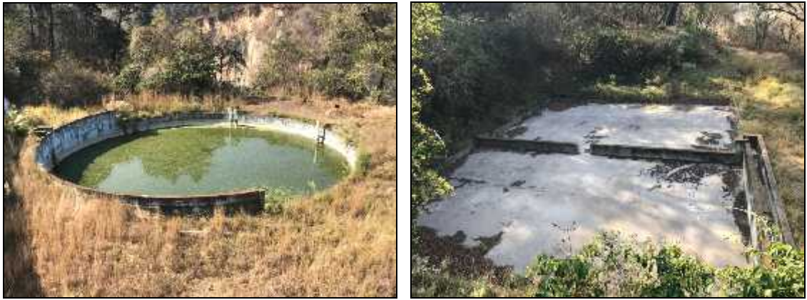
Figura 11. Digestor de lodos y patio de secado
