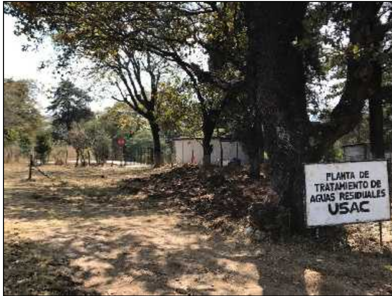
Figura 3. Acceso a la PTAR de la USAC
