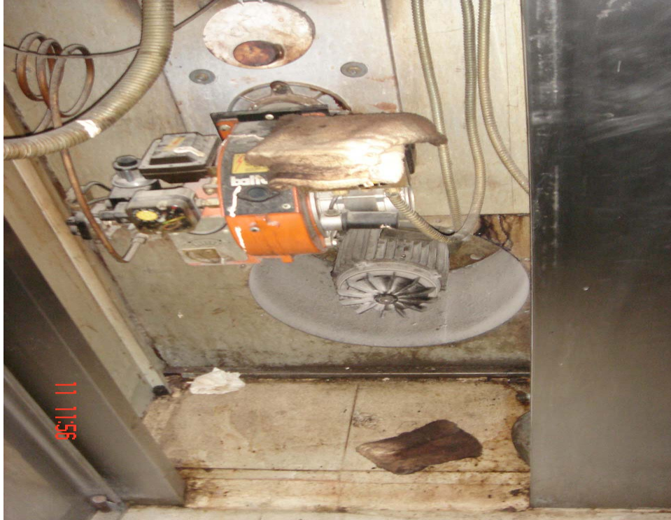
Figura 22. Material inflamable en área de quemador de horno
