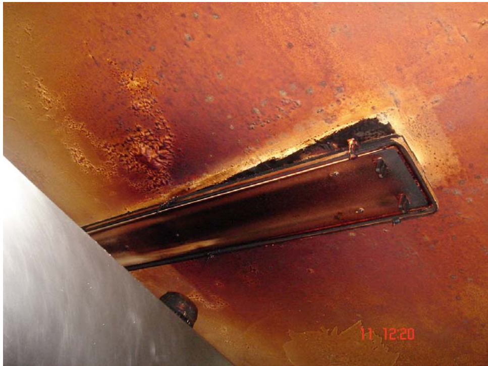
Figura 34. Falta de ventilación en área de hornos
