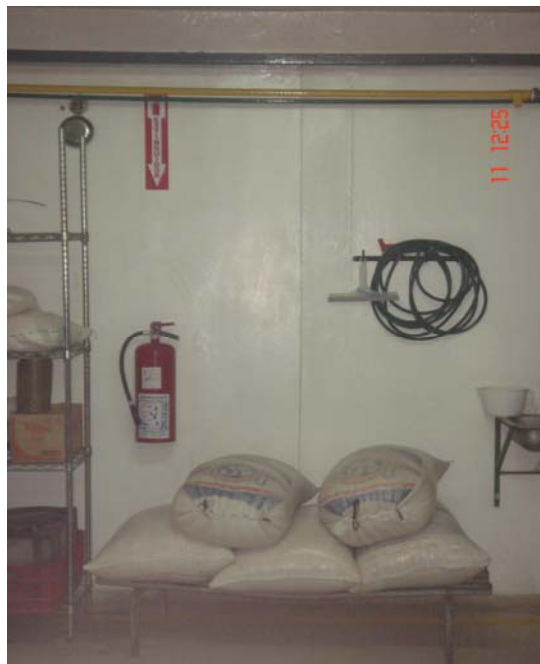
Figura 28. Obstrucción de extintor
