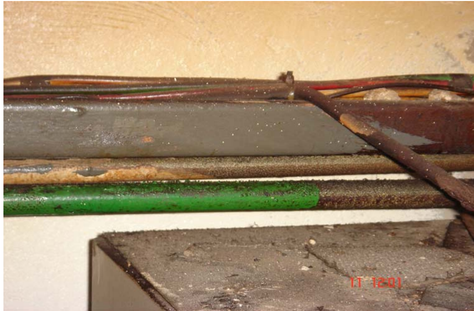
Figura 40. Conexiones de gas, agua y electricidad
