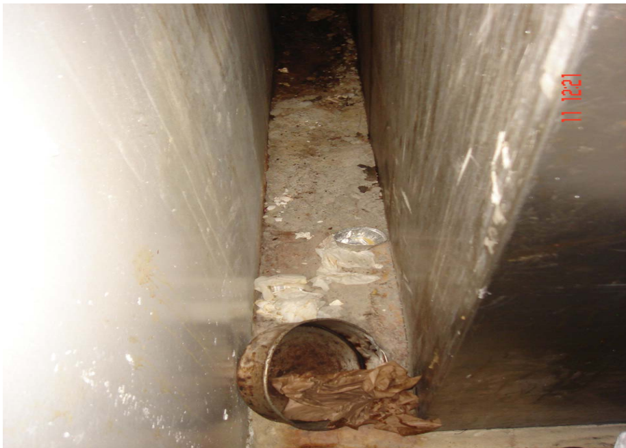
Figura 24. Material inflamable atrás de horno
