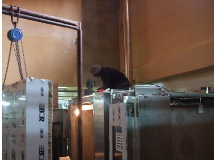
Figura 13. Armado e instalación de hornos Werner.
