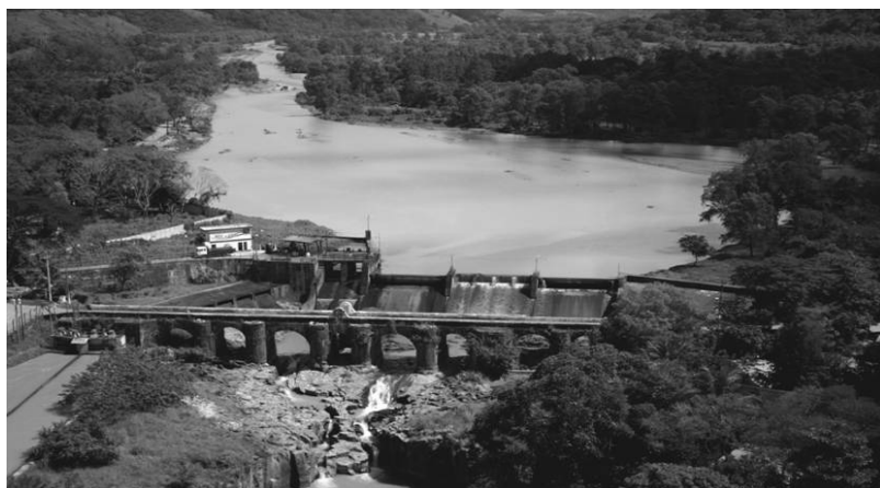
Figura 24 Foto panorámica de la presa hidroeléctrica Los Esclavos
