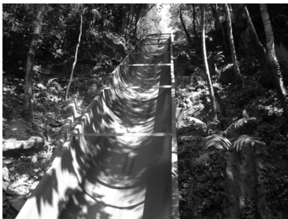
Figura 27 Canal de desfogue hidroeléctrica Los Esclavos
