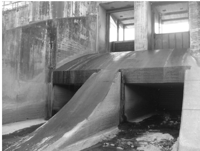
Figura 25 Foto de aliviaderos hidroeléctrica Los Esclavos
