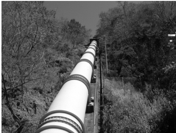
Figura 26 Descargadero hidroeléctrica Los Esclavos
