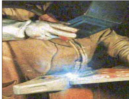
Figura 31. Equipo para la aplicación con soplete de gas
