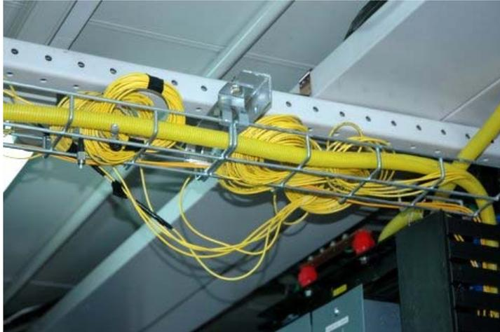
La fibra debe utilizar el corrugado instalado no dejarla expuesta ni tendida como se aprecia en la fotografía.
