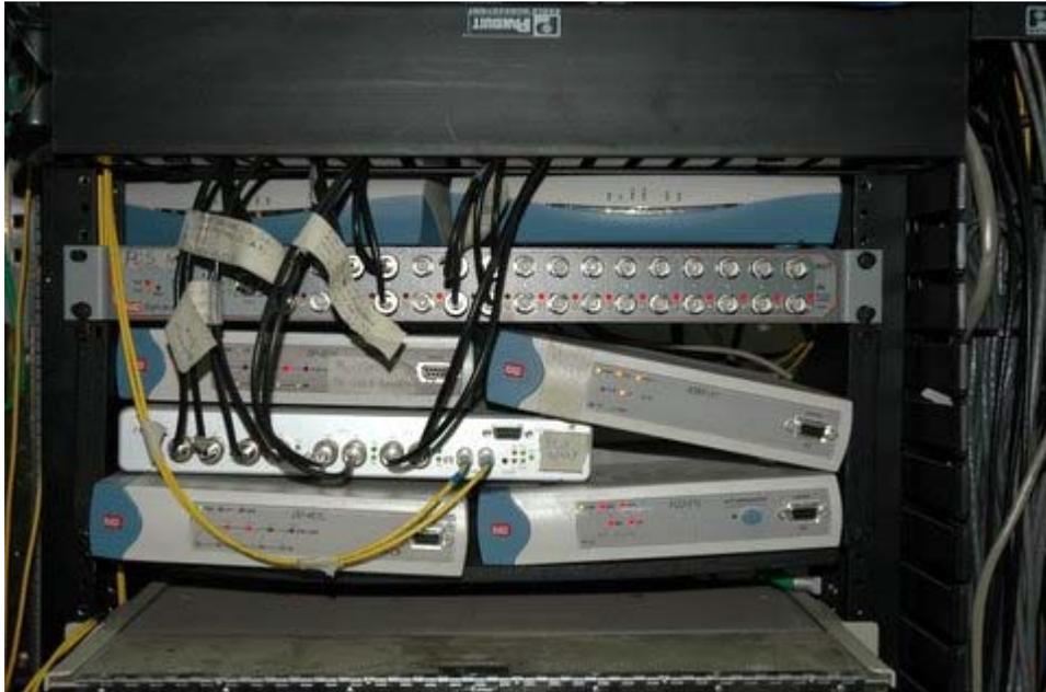
Equipo mal instalado no se deben colocar equipos amontonados.
