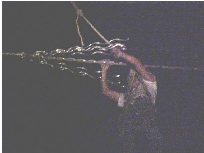
Figura 41. Colocación de Splaices en conductor deshilado
