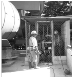
Figura. 12: Construcción de caseta para compresores
