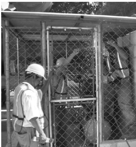
Figura. 44: Aplicación de soldadura
