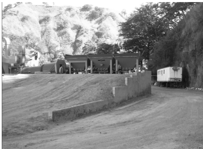
Figura. 11: Rampa para carga de agregados
