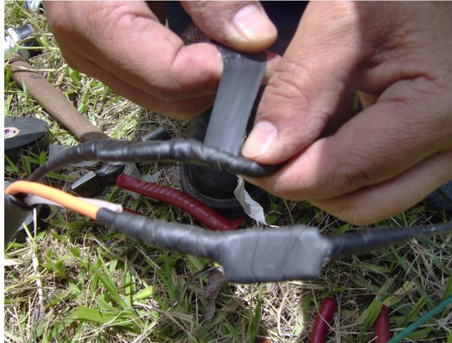
**Figura 42. Empalme de cable, utilizando cinta eléctrica de PVC**
