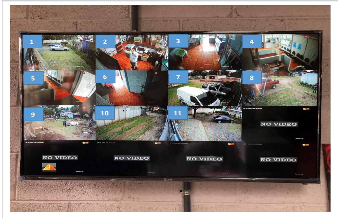
Figura 97. Montaje del sistema de video vigilancia CCTV
