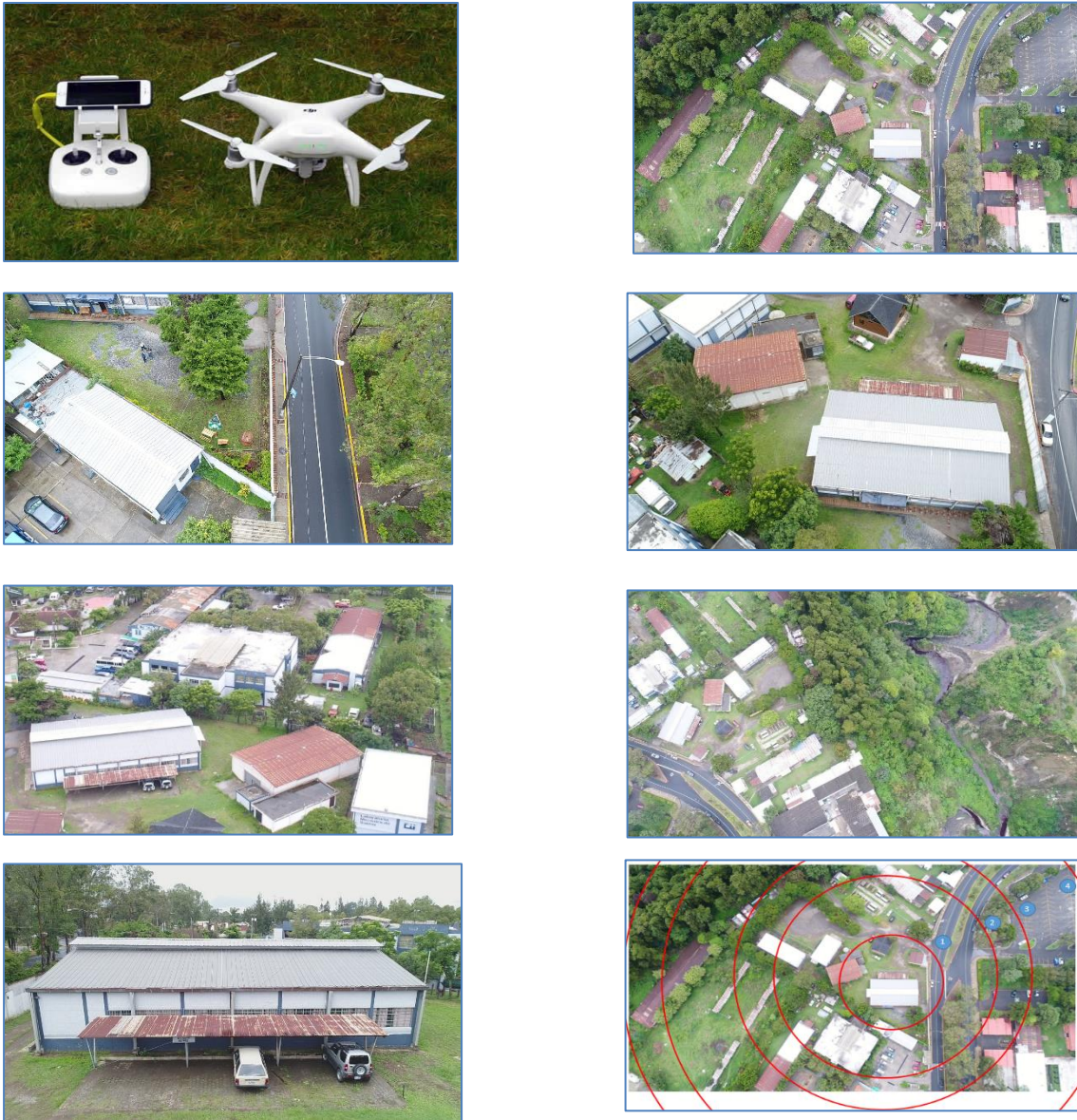
Figura 51. Dron y tomas aéreas de las instalaciones de EPS
