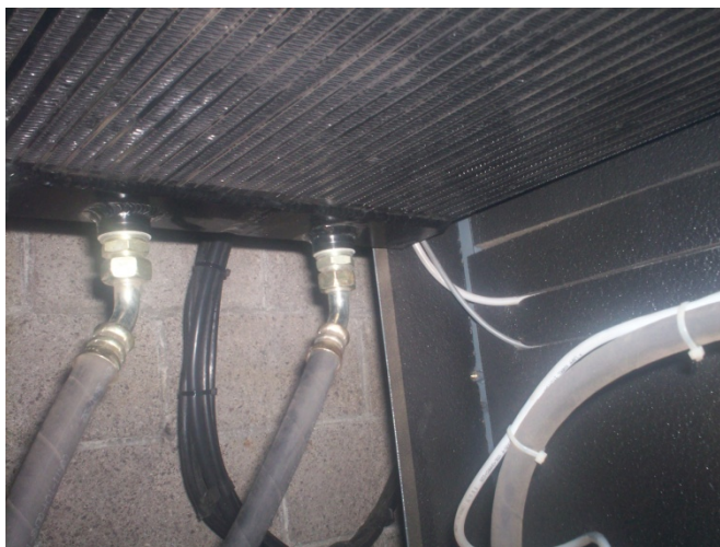
Figura 47. Enfriador aire-aceite
