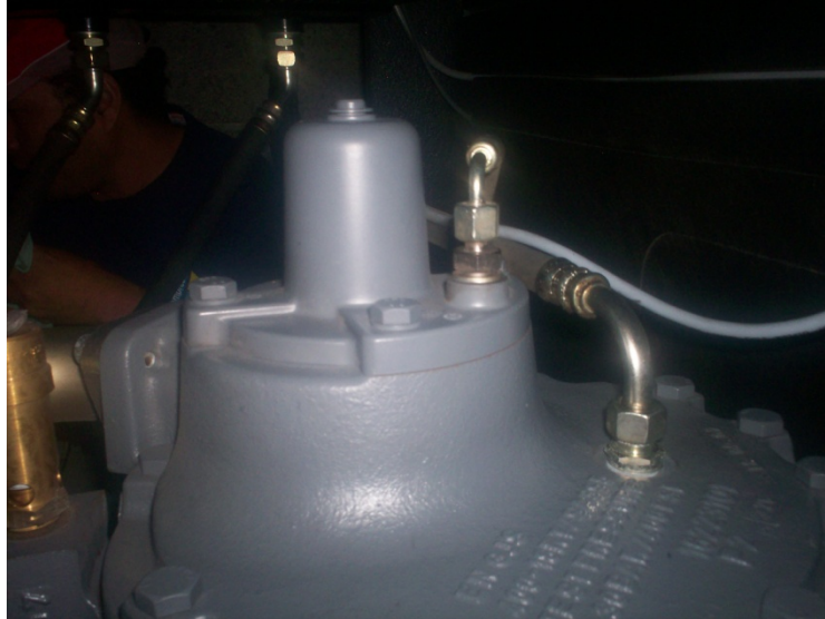
Figura 46. Trampa de agua
