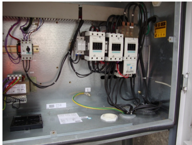
Figura 34. Diagrama de un arrancador estrella delta
