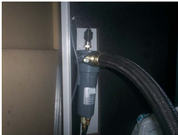
Figura 46. Trampa de agua
