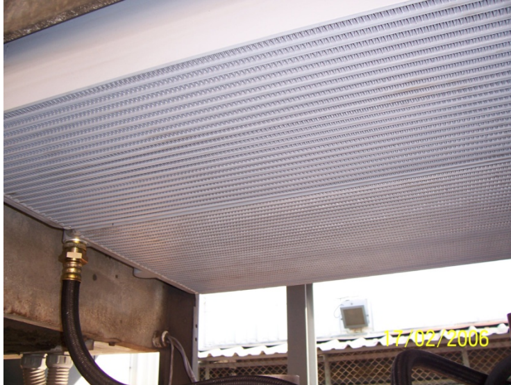
Figura 48. Enfriador aire-aceite
