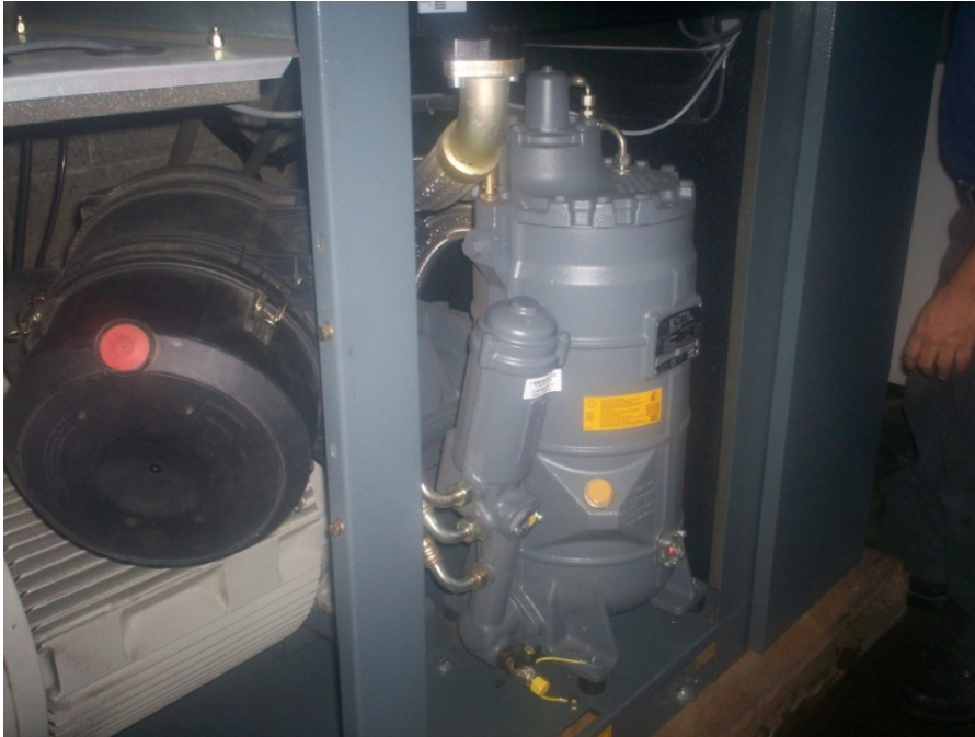
Figura 56. Depósito de aceite en compresor
