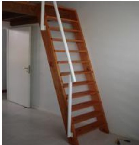
Figura 12. Escalera marina fija
