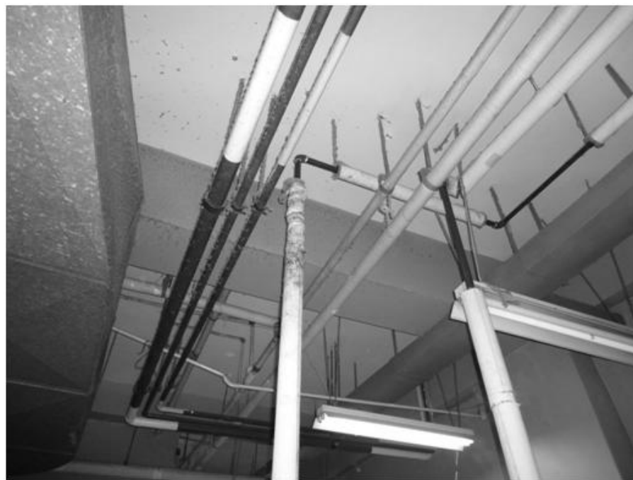
Figura 30. Situación actual de tuberías y accesorios
