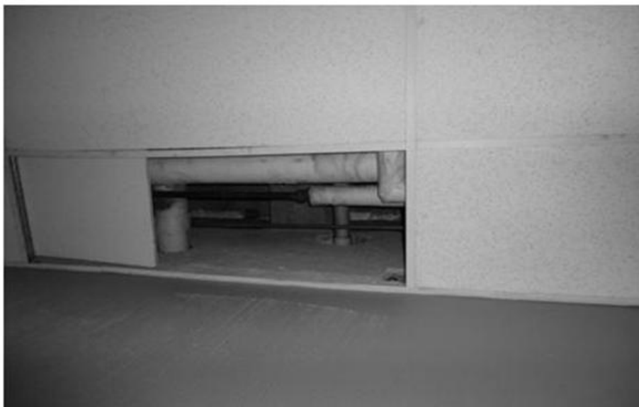
Figura 29. Situación actual de tuberías
