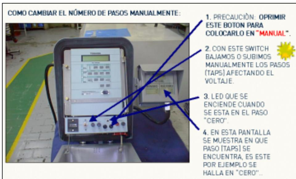
**Figura 38. Diagrama unifilar (monofásico). Maniobras para poner en servicio una unidad reguladora de tensión.**
