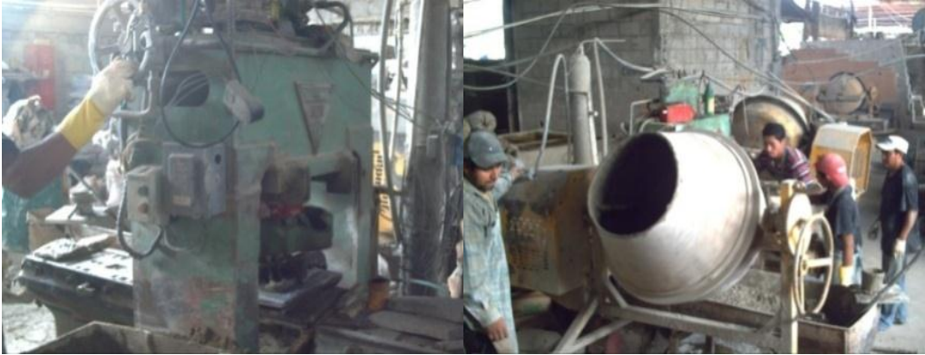
Figura 33. Mantenimiento de la mezcladora en la bodega de materiales
