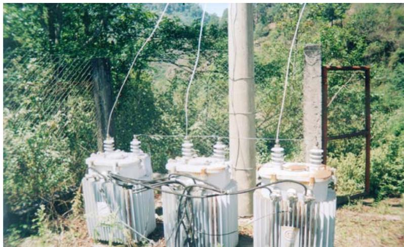
**Figura 14.** Transformador de potencia de generador japonés
