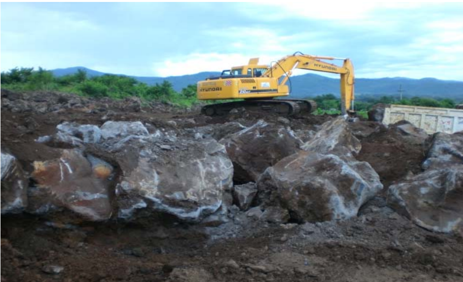
Figura 33. Excavadora Hyundai Robex 210 LC-3.
