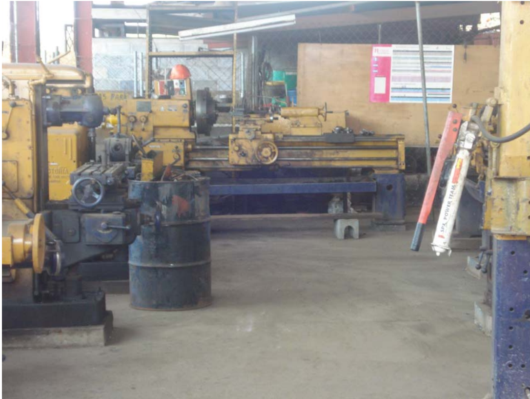
Figura 3. Taller de Mantenimiento
