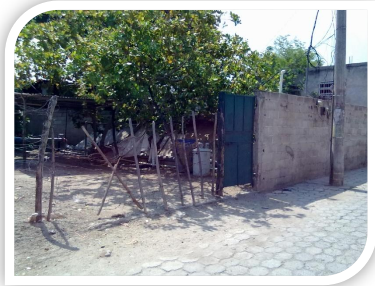
Figura 4. Estado actual pozo Escuela de Varones
