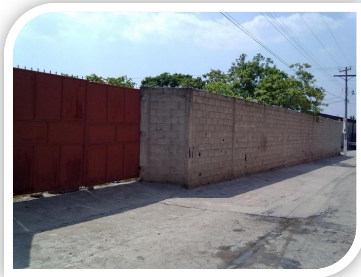
Figura 6. Estado actual pozo San francisco, fachada lateral
