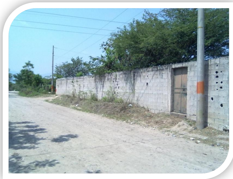
Figura 7. Estado actual pozo 5, fachada frontal
