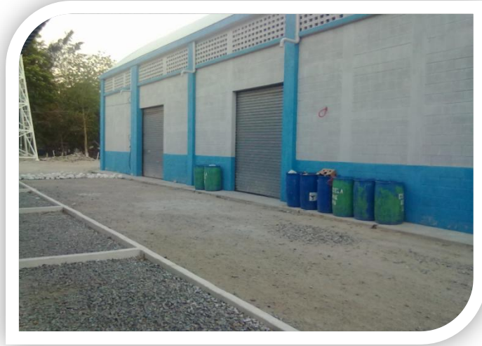
Figura 25. Puertas de acceso mercado municipal
