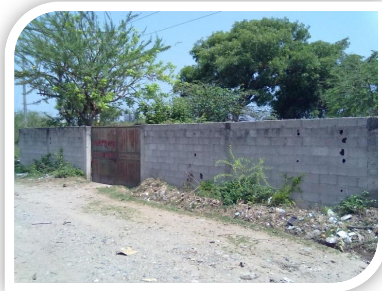
Figura 8. Estado actual Pozo 5, fachada lateral
