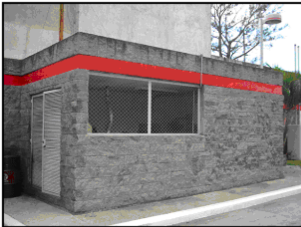
Figura 5. Cuarto de máquinas
