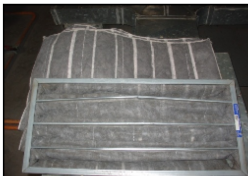
Figura 15. Filtro de bolsa de 85% de eficiencia
