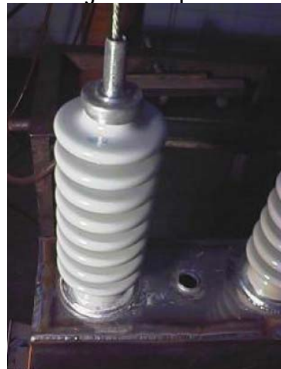
Figura 15. Aislador o Bushing de un Capacitor.
