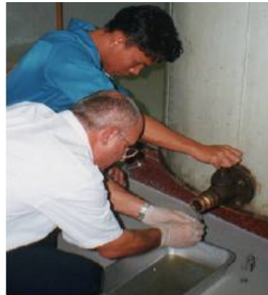
Figura 38: Drenado de aceite de transformadores utilizando balde de acopio.
