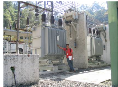
Figura 117. Inspección a planta EMPAGUA
