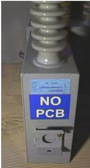
Figura 27. Capacitor Monofásico sin PCBs.
