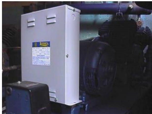
Figura 25. Capacitor instalado en un motor de Inducción.
