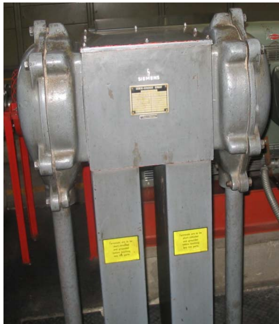
Figura 24. Fotografía de Capacitor con PCBs.
