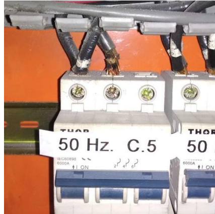
Figura 21. Cable dañado
