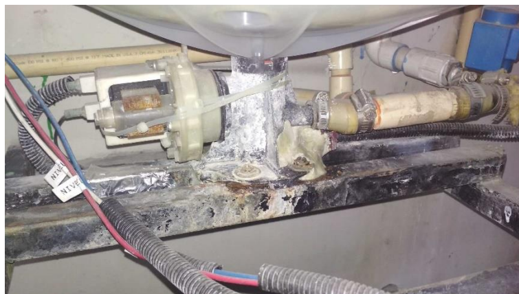
Figura 30. Sarro y óxido en la base del barril
