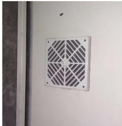
Figura 15. Compartimiento de ventilación sin uso
