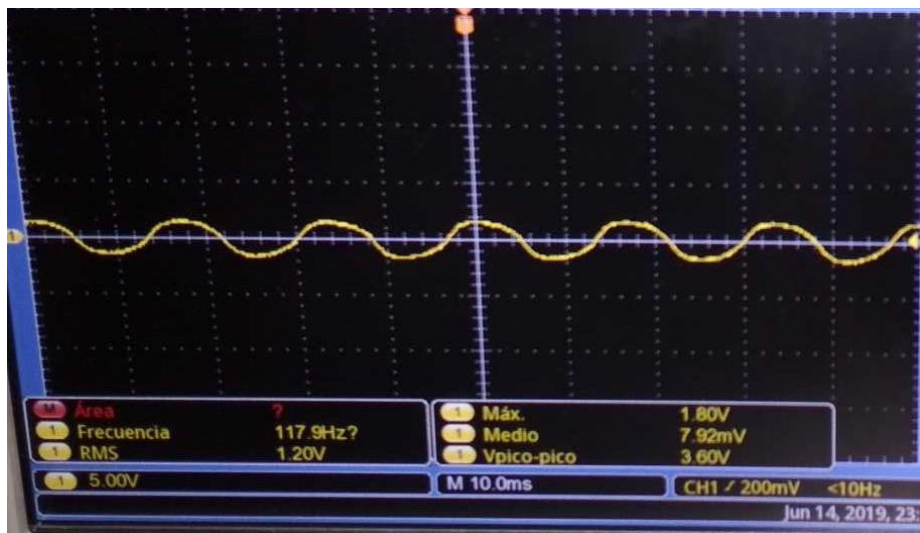
Figura 49. Tensión inducida en variac con conexión a tierra
