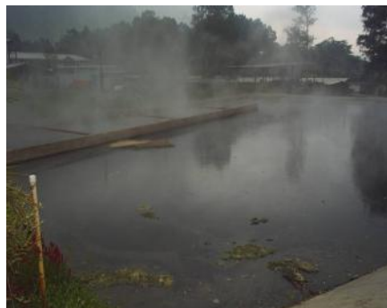
Figura 15. Sistema de lagunaje
