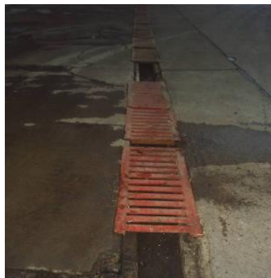
Figura 11. Sistema de rejas para captación de residuos
