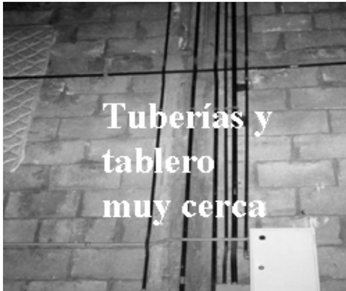
Figura 36a. **Tuberías de teléfonos cerca de ductos eléctricos**
