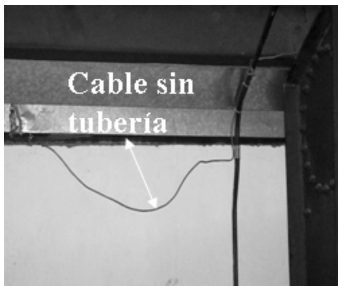
Figura 35c. Cables telefónicos sin tubería de protección
