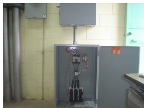
Después de la instalación del banco
