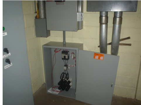
Después de la instalación del banco
