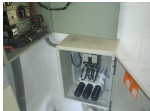
Después de la instalación del banco
