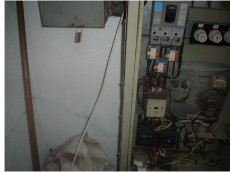
Después de la instalación del banco
