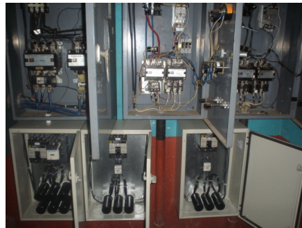
Después de la instalación de los bancos
