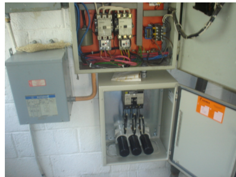
Después de la instalación del banco
