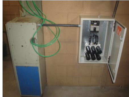
Después de la instalación del banco
