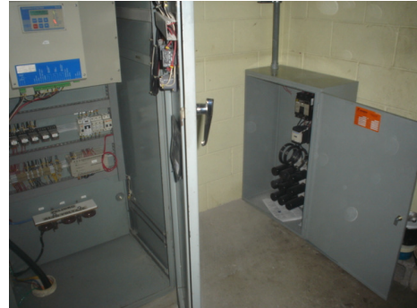
Después de la instalación del banco
