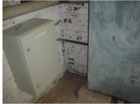
Después de la instalación del banco
