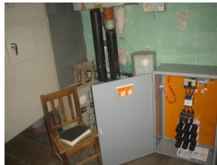
Después de la instalación del banco
