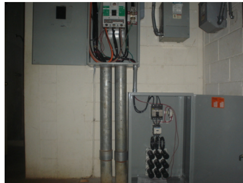
Después de la instalación del banco
