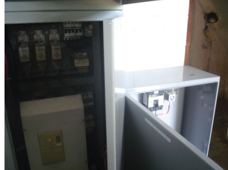
Después de la instalación del banco
