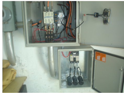
Después de la instalación del banco
