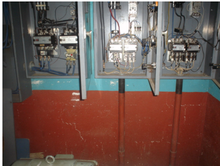
Antes de la instalación de los bancos
