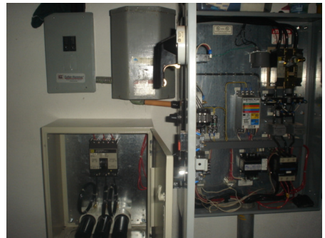
Después de la instalación del banco
