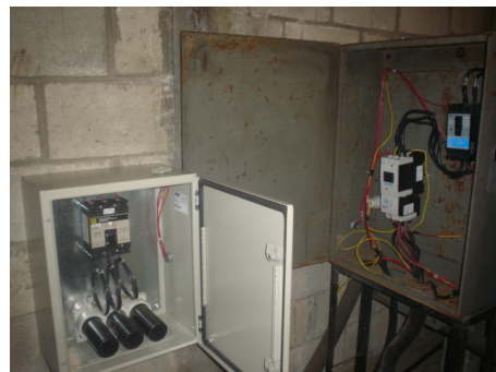
Después de la instalación del banco
