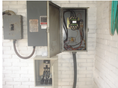
Después de la instalación del banco
