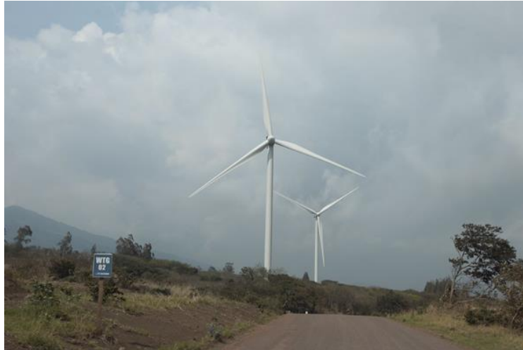
Figura 2. Parque eólico – San Antonio Guatemala
