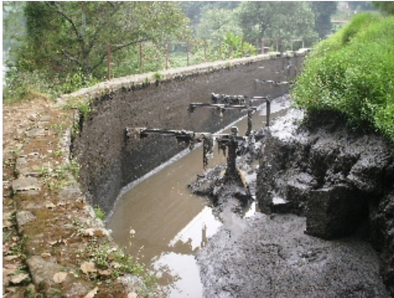
Figura 8. Vista del desarenador
