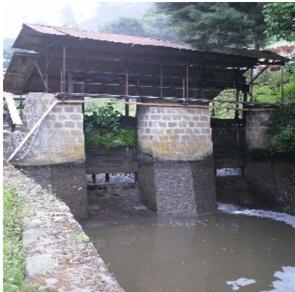
Figura 7. Compuerta de entrada al desarenador
