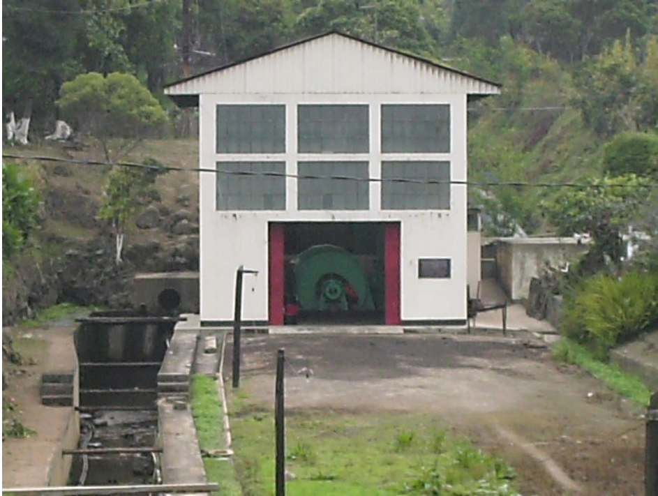
Figura 31. Casa de máquinas
