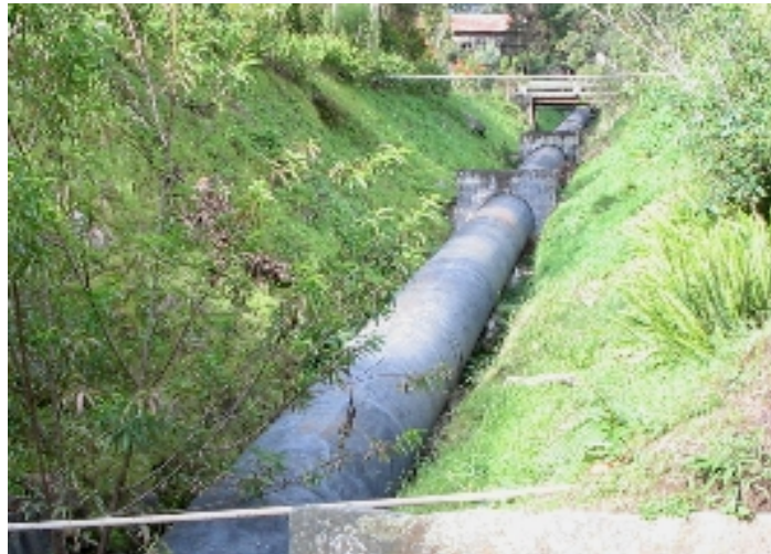
Figura 14. Otra vista de la tubería de presión
