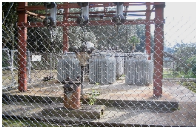
Figura 29. La salida eléctrica del generador
