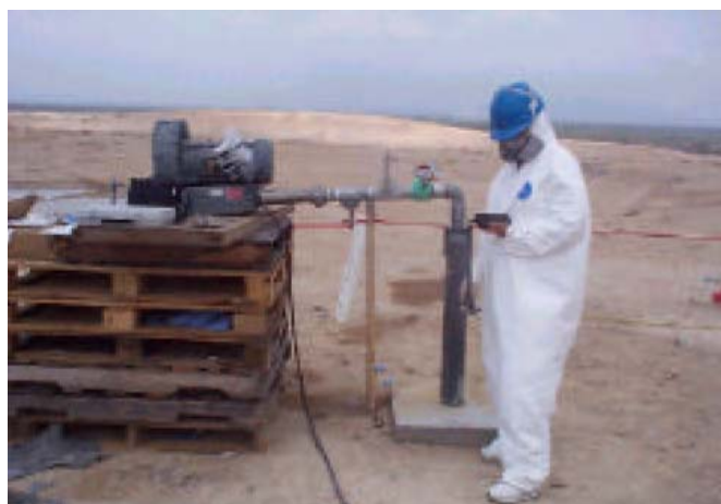
Figura 31 Control de biogás
