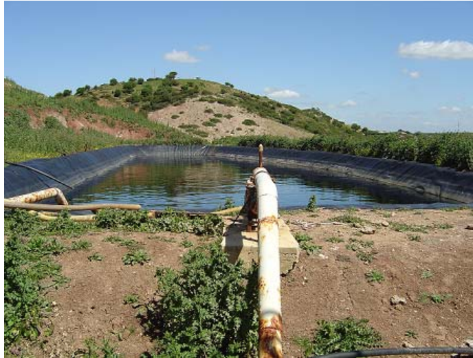
Figura 26 Piscina de evaporación de lixiviados
