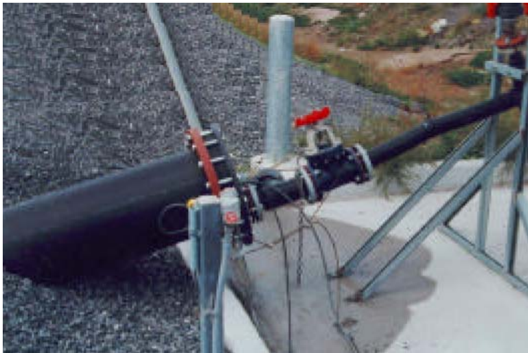
Figura 29 Control de movimiento de biogás
