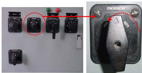
Se debe verificar los voltaje entre el generador y la barra estén en 12.4 Kv, si el valor del voltaje del generador es menor de 12.4 Kv se debe ajustar colocando la manija del regulador manual en posición de aumento (raise), si el valor del voltaje es mayor a 12.4 Kv se debe ajustar colocando al manija del regulador manual en posición disminuir (lower).
