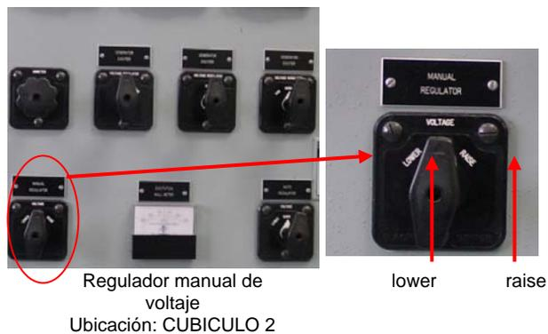
Verificar la velocidad en el sincronoscopio a manera de que la aguja quede en el centro, si tiene velocidad lenta se debe aumentar moviendo la manija del gobernador de la turbina a la posición de aumento (raise), si la velocidad es elevada, se debe reducir la velocidad colocando la manija en posición de disminuir (lower).
