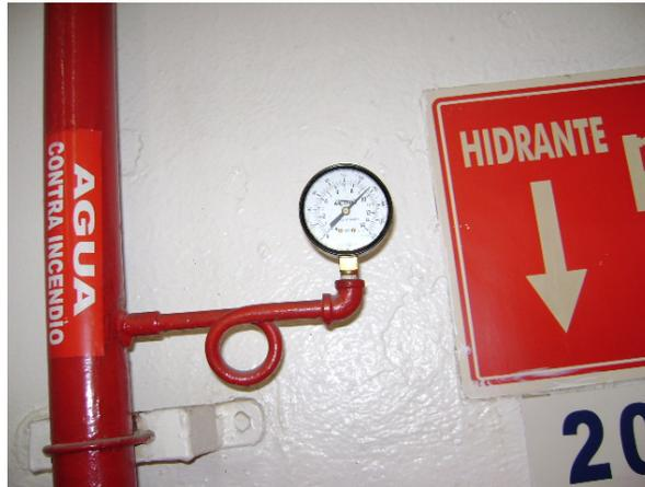
**Figura 43. Hidrante instalado con sus accesorios.**
