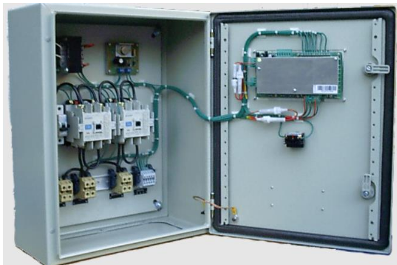
Figura 68. Tablero de transferencia automático
