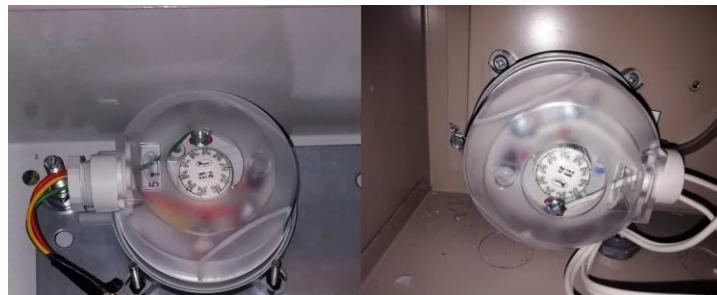
Figura 43. Interruptor de presión diferencial Dwyer
