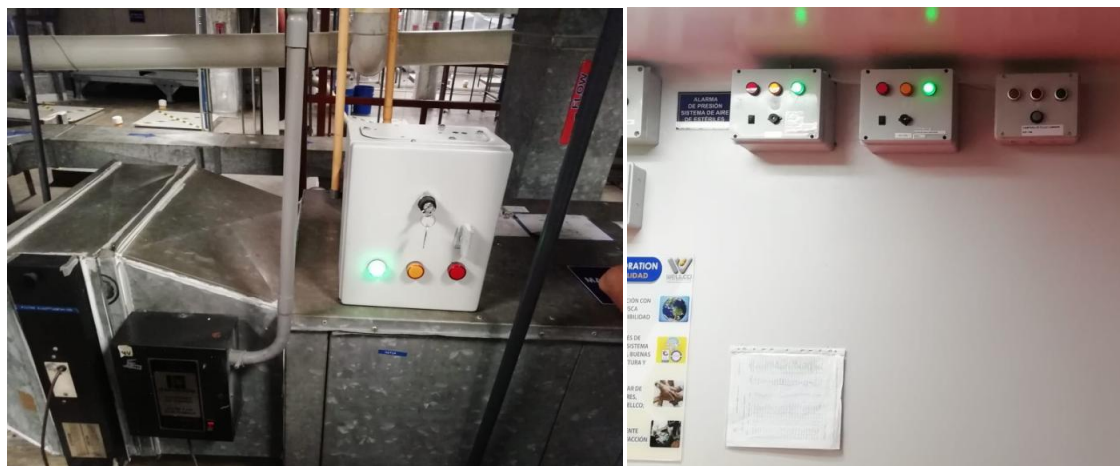
Figura 72. Instalación del indicador y alarma de flujo de aire
