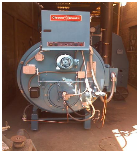
Figura 13. Caldera Pirotubular
