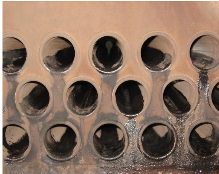
Figura 21. Fluses de la caldera
