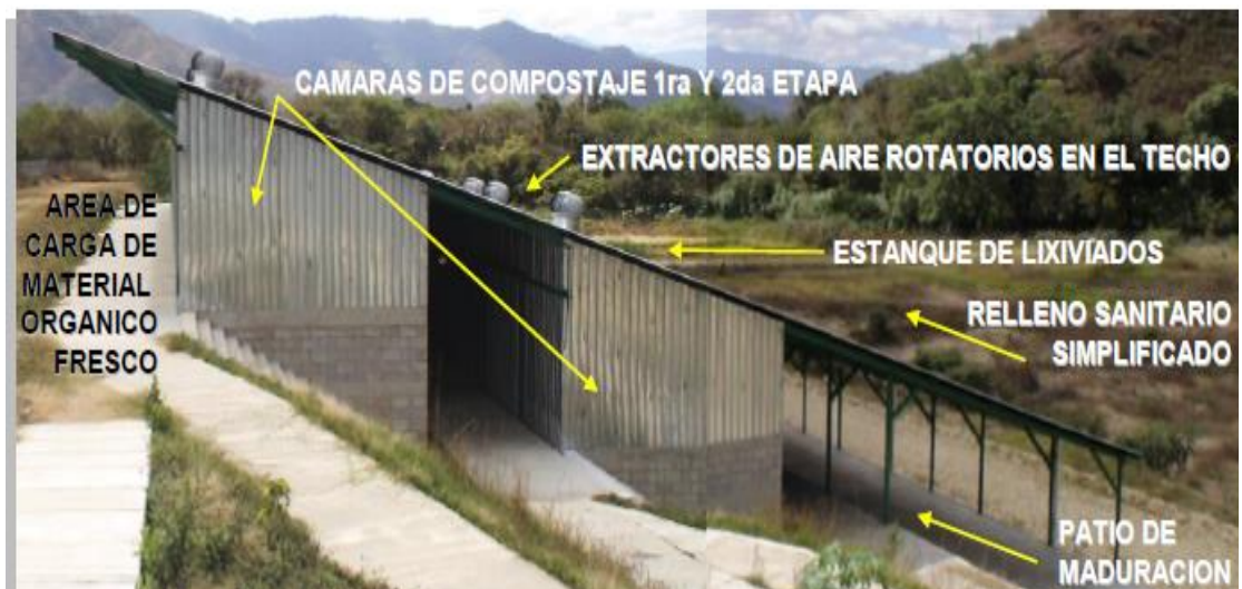
Figura 10. Cámaras de ventilación por aireación convectiva de Rabinal
